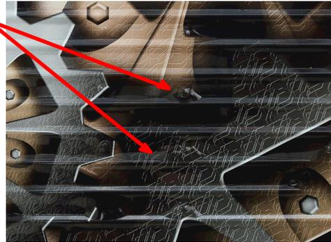
Acá se muestra el levantamiento sobre remaches en superficies planas.
